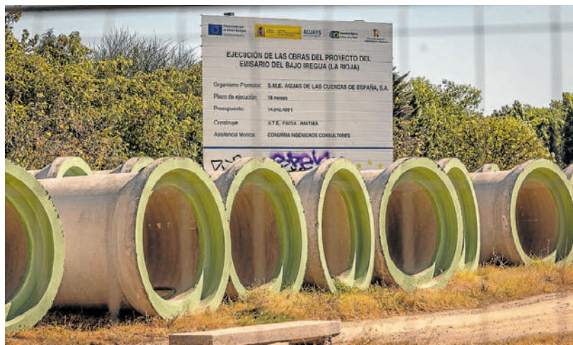
Tuberías almacenadas desde hace meses en uno de los accesos al parque del Iregua de Logroño. JUSTO RODRÍGUEZ
